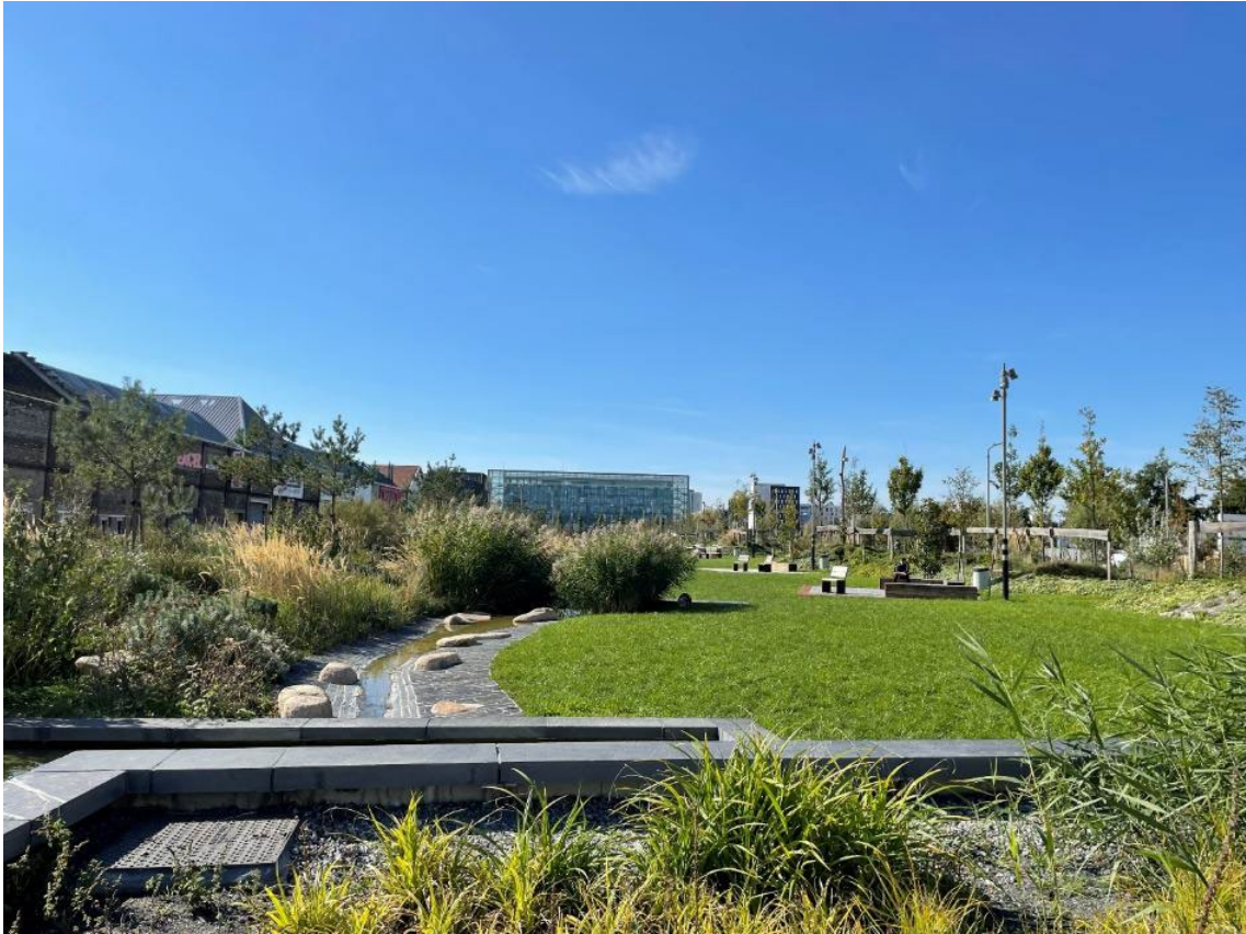
Tranche 3 - Bassin de filtration en amont de la rivière
